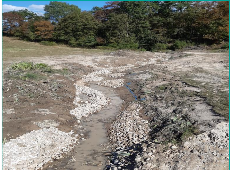
Pendant les travaux
